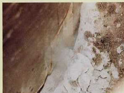
▲一軸圧縮強度196MPa(2,000kgf)/cm 2 の花崗岩の切削状況
