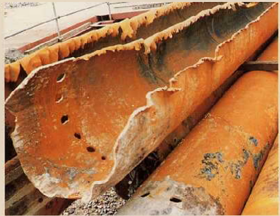
掘り出された鋼管杭▶
