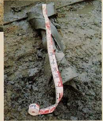
掘り出されたH鋼杭▲
