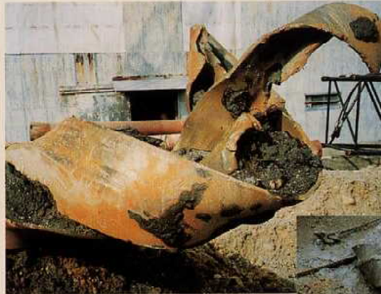
掘り出されたH鋼杭▲
